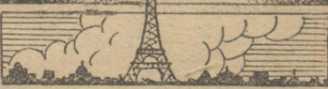
La Torre Eiffel fué terminada el 31 de marzo de 1889, hace poco más de setenta y dos años. Tiene 300 metros de altura y 100 de separación entre cada uno de sus pies. Pesa 7.000 toneladas. Está compuesta por 12.000 piezas metálicas y se emplearon 2.500.000 remaches y tornillos. La temperatura puede variar hasta 15 grados entre su base y la parte más alta. En días de viento muy fuerte, las oscilaciones de su cima llegan a alcanzar 12 centímetros.
